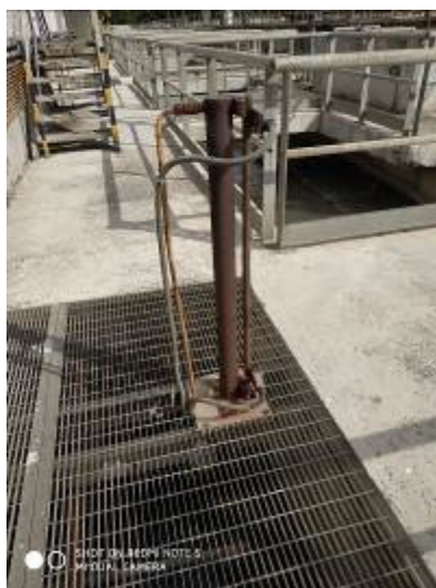
Particolare pistone valvola telescopica
