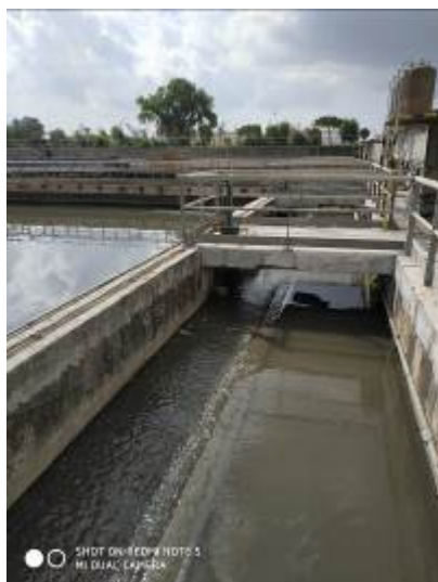
Paratoia su vasca di sedimentazione
