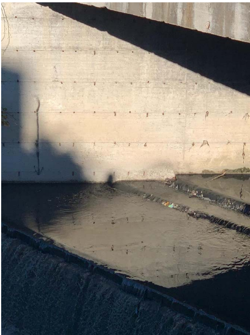
Vista di dettaglio delle n.2 griglie trasversali a guardia del derivatore, della localizzazione della sezione di derivazione di fondo in dx idraulica della Galleria Spinelli (indicata dalla freccia verniciata sulla parete) e della soglia di stramazzo nel Canale di Quarto.
