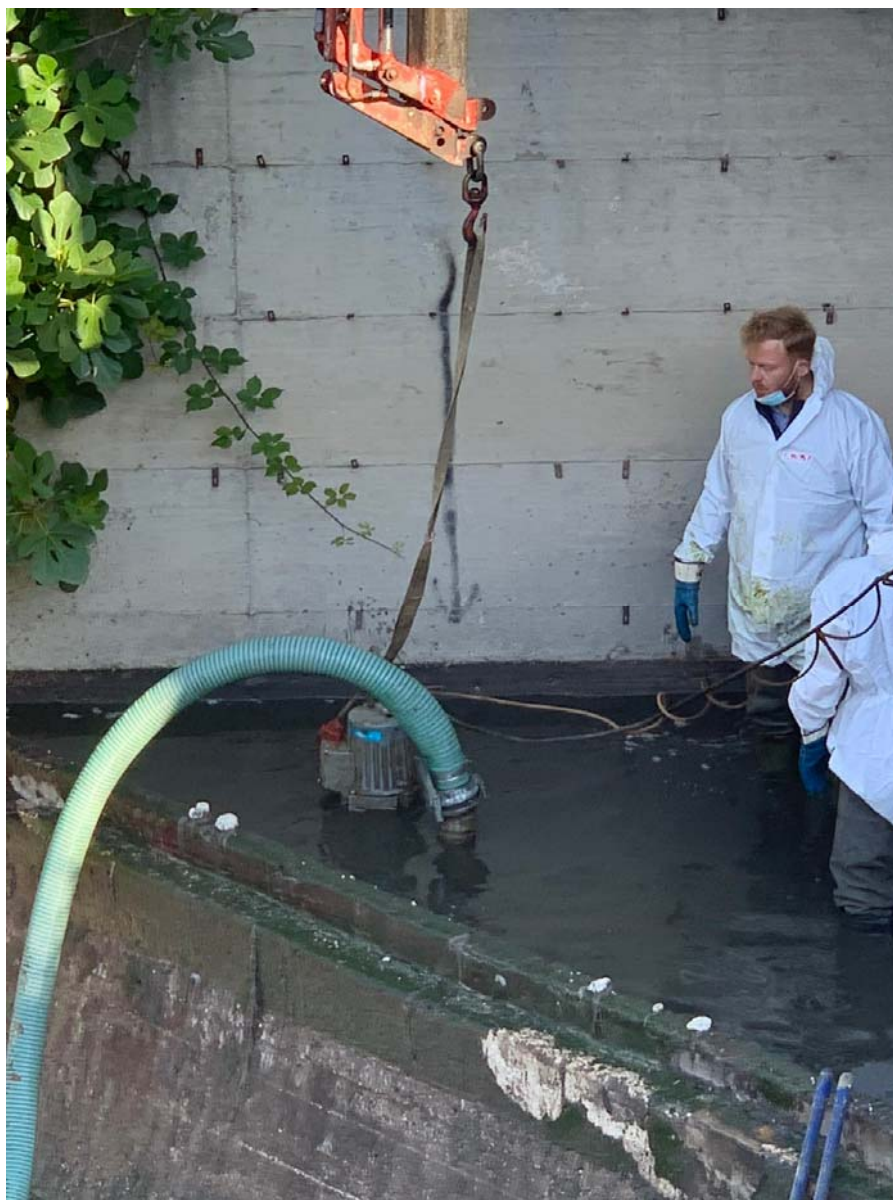
Fase di installazione pompa sommersibile per aggottamento reflui dall'area del derivatore.
