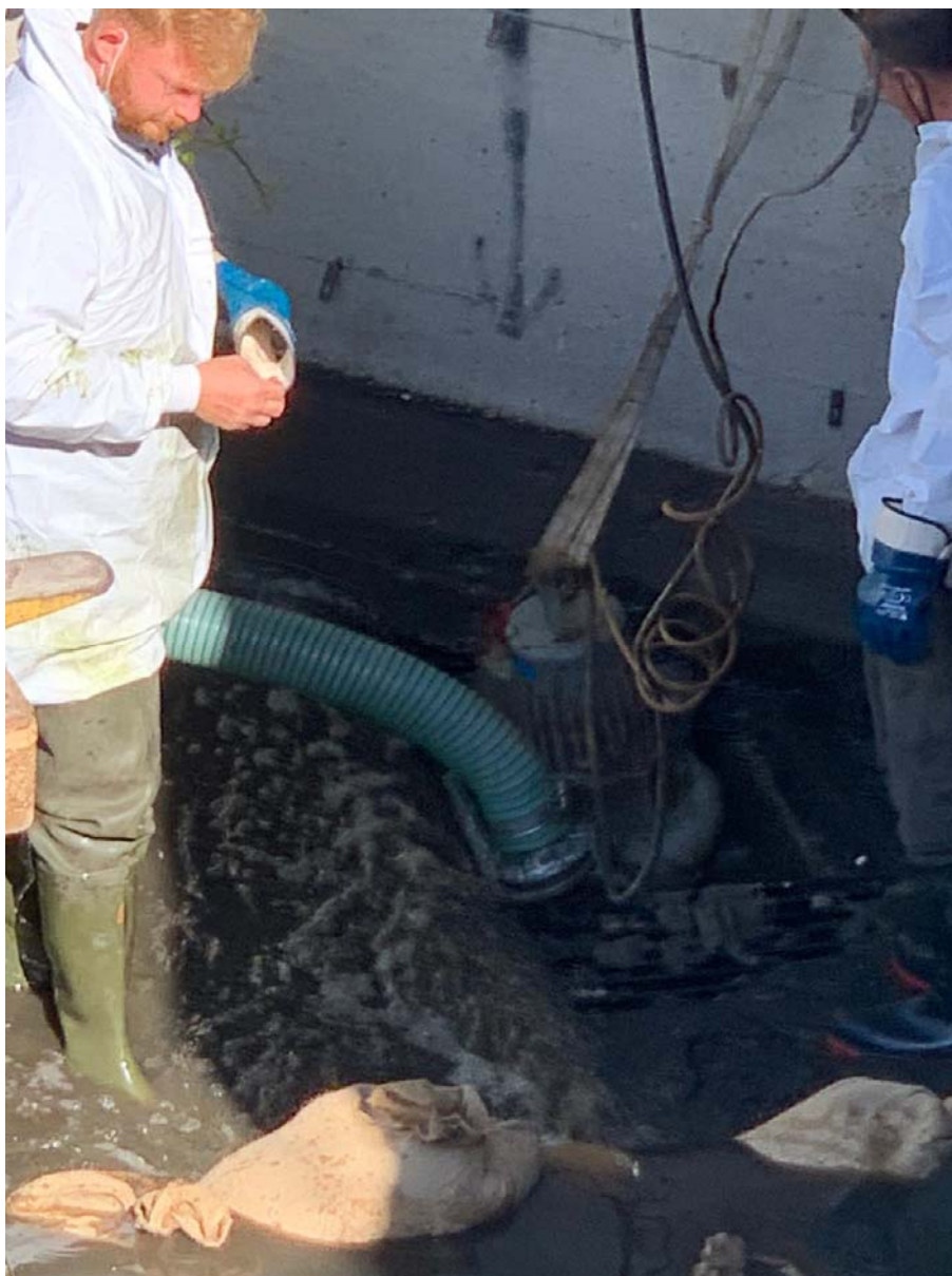
Messa a giorno della luce di derivazione; vista della tura in sacchi di sabbia e della griglia orizzontale a protezione del derivatore.
