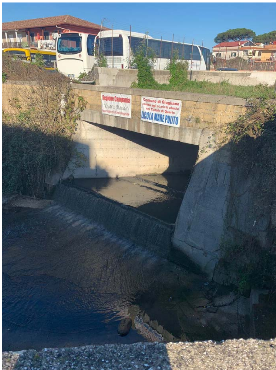
Vista della sezione terminale della Galleria Spinelli (scatolare in c.a.) e dello scarico nel Canale di Quarto
