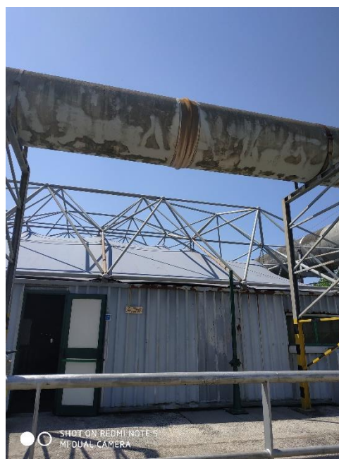
Tubazione diametro 2000 mm su rack
