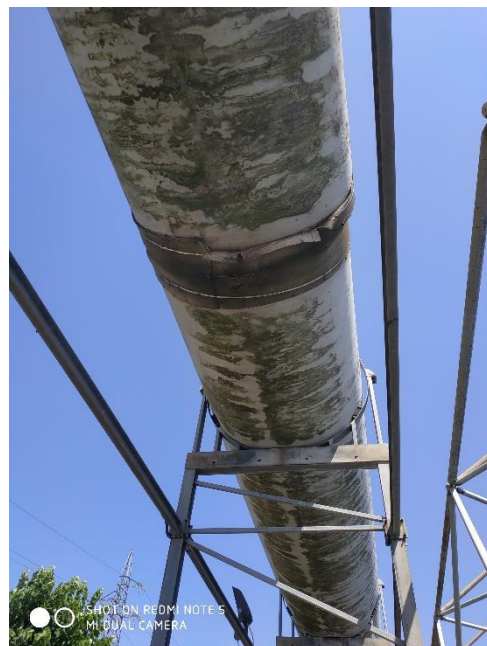
Tubazione diametro 2000 mm su rack
