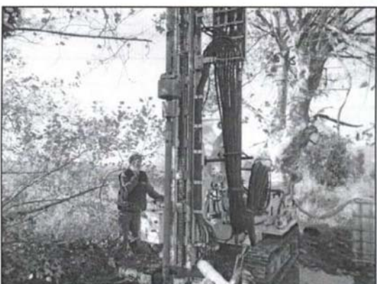
Esecuzione Prova SPT
